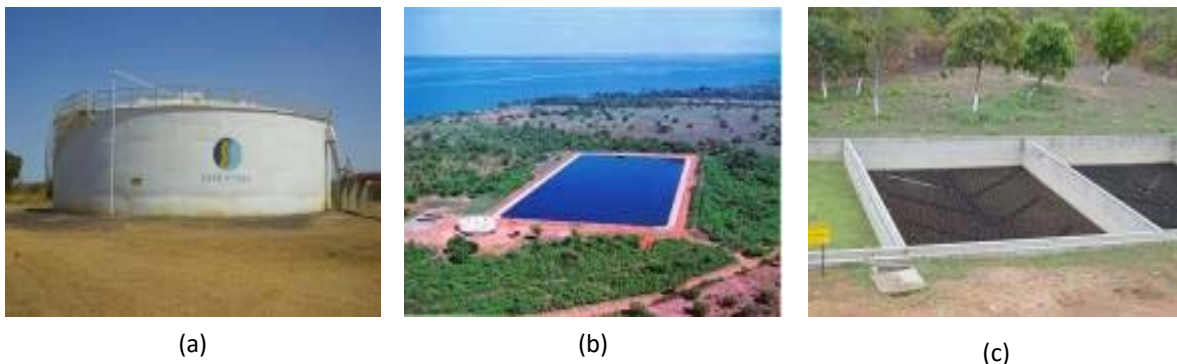
Figura 3. Tratamento Biológico da ETE: (a) Reator UASB, (b) lagoa facultativa e (c) leitos de secagem.
