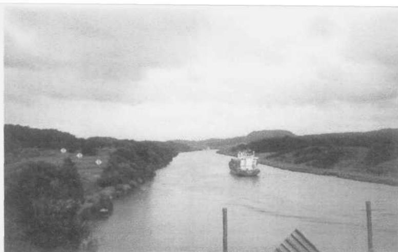
Tránsito simultáneo de naves Panamax por el Corte Gaillard o Culebra
