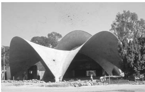
Hotel Casino de la Selva en Cuernavaca. Vista de los cascarones del restaurante, en primer término, y del auditorio, atrás, durante su construcción. Félix & Dorothy Candela Archive, Princeton University
