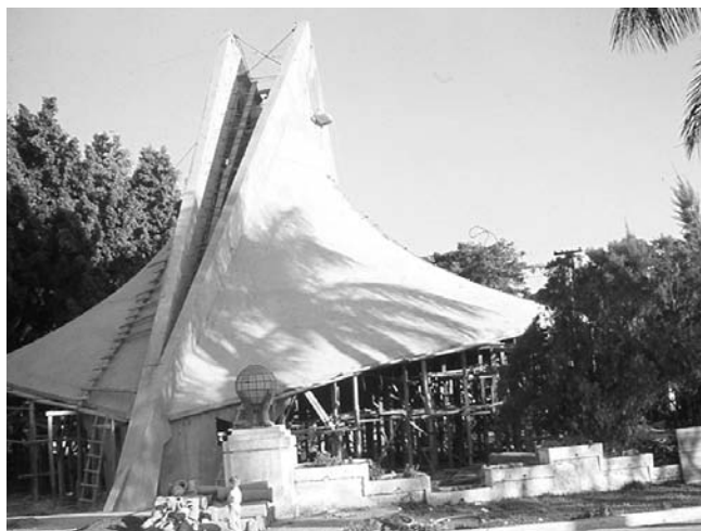
El Salón Mambo en construcción. Fotografía: Felix & Dorothy Candela Archive, Princeton University Izquierda: Desarrollo geométrico del paraboloides hiperbólico utilizado en la cubierta del Salón Mambo. Dibujo: Eduardo Alarcón
