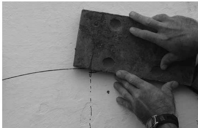
Colocación de BTC para clave de arco
