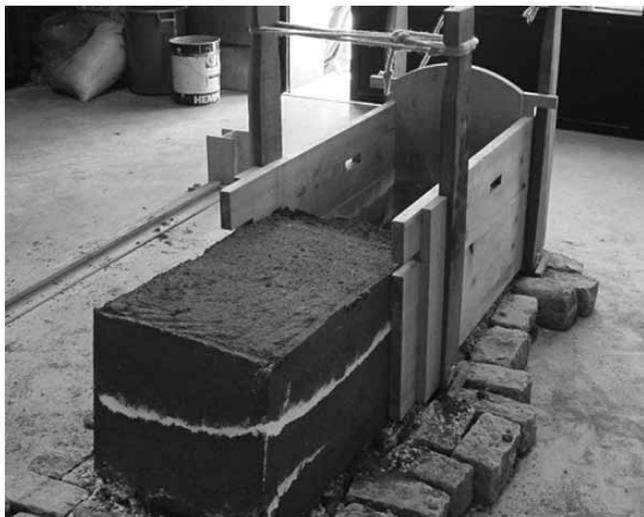
Muro de tapia en su secado de madera
