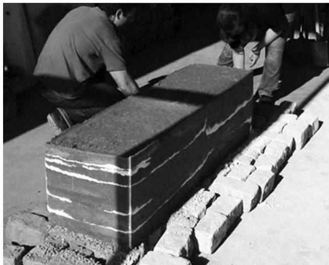
Muro de tapia al que se le ha retirado el encofrado
