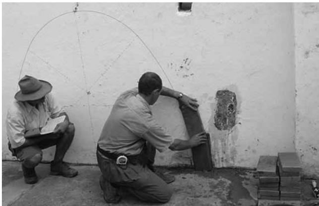
Trazo en muro para construcción de modelo de arco en BTC
