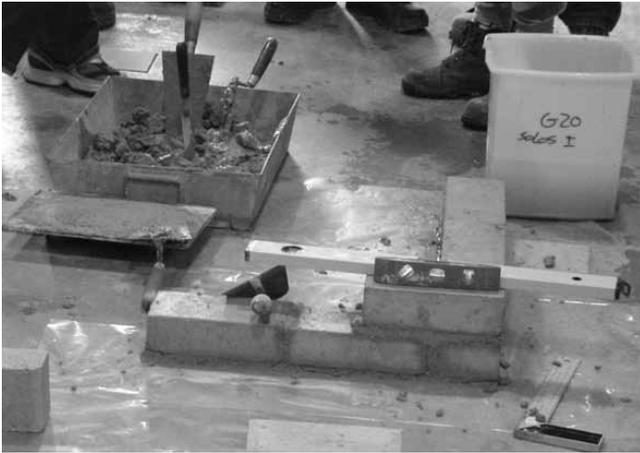
Solución en esquina de muro con base en BTC
